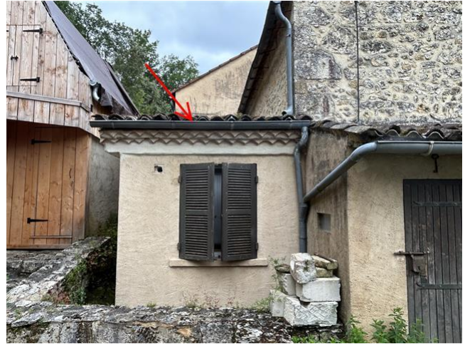
003 : fibre ciment Logement/Salle d'eau Logement/Salle d'eau (niv:0)
