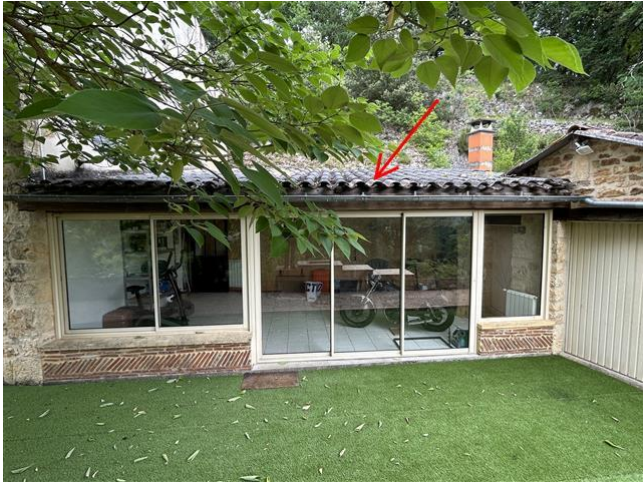
001 : fibre ciment Logement/Véranda Logement/Véranda (niv:0)
