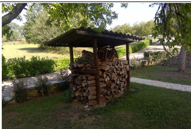
036 : Plaques ondulées Annexes/Abri bois Annexes/Abri bois (niv:0)
