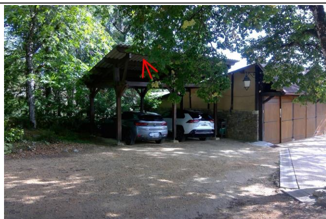
037 : Plaques ondulées Annexes/Abri voiture Annexes/Abri voiture (niv:0)
