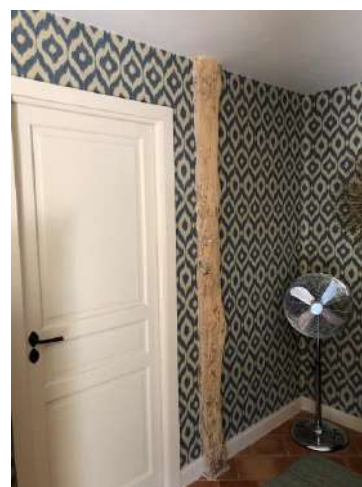
INS006 Maison - Logement / Chambre PH8 : Poteau Insectes à Larves Xylophages (ILX)
