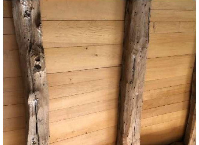
INS008 Maison - Logement / Chambre 3 PH11 : Poutre maitresse Insectes à Larves Xylophages (ILX)
