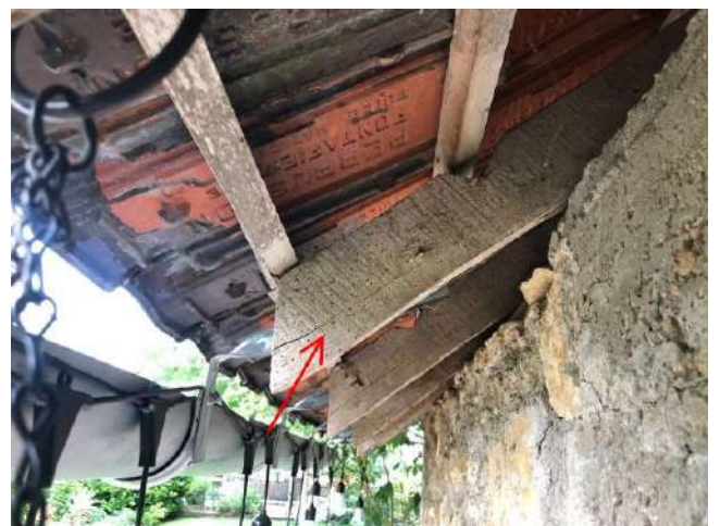
INS011 Maison - Buanderie / Buanderie PH3 : Poutre maitresse Insectes à Larves Xylophages (ILX)
