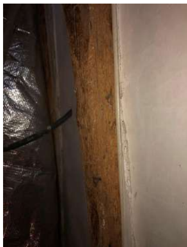
INS002 Maison - Logement / Palier PH4 : Poutre maitresse Insectes à Larves Xylophages (ILX)
