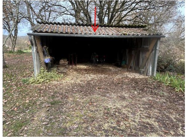
002 : fibre ciment Abri agricole/Abri agricole Abri agricole/Abri agricole (niv:0)
