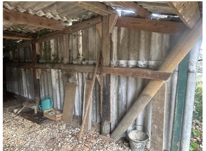
003 : fibre ciment Abri agricole/Abri agricole Abri agricole/Abri agricole (niv:0)
