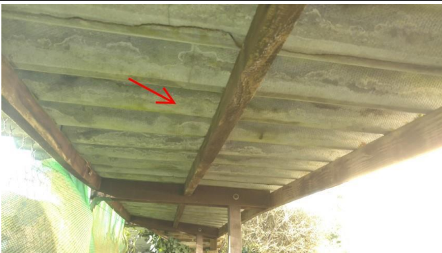
004 : Plaques ondulées en couverture Annexe/Bucher - PRE:003
