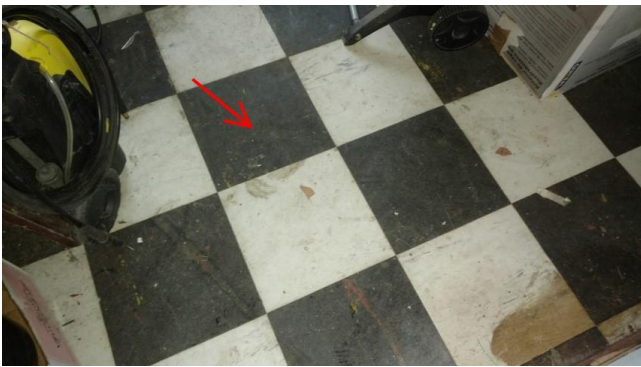
001 : Dalles de sol Annexe/Atelier - PRE:001
