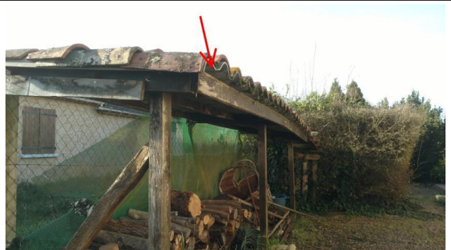
004 : Plaques ondulées en couverture Annexe/Bucher - PRE:003
