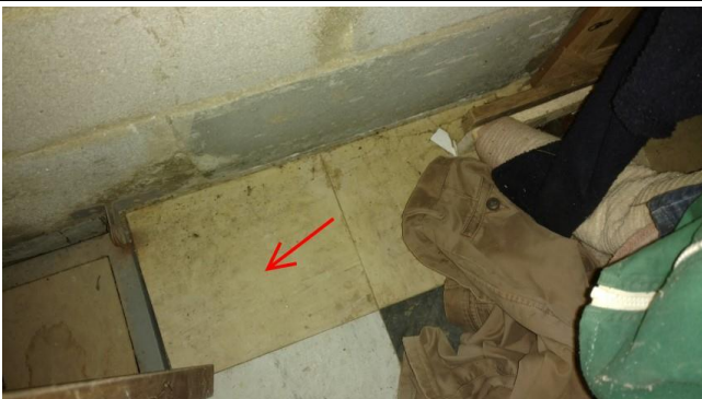
003 : Dalles de sol Annexe/Atelier
