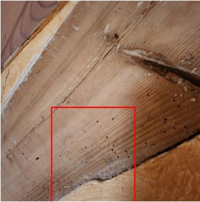
Par exemple trous de sortie de petites vrillettes.
