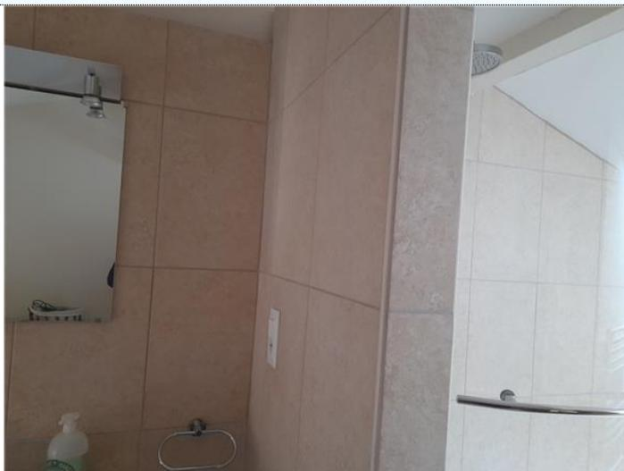
**Description :** Local contenant une baignoire ou une douche : l'installation électrique ne répond pas aux prescriptions particulières appliquées à ce local (adéquation entre l'emplacement où est installé le MATERIEL ELECTRIQUE et les caractéristiques de ce dernier – respect des règles de protection contre les chocs électriques liées aux zones).
