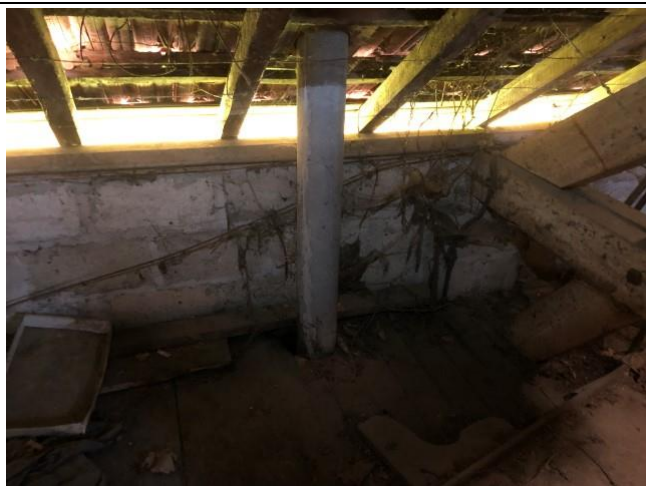
001 : fibre ciment Ancien bar/Grenier
