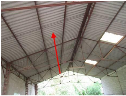
Photo n° PhA003 Localisation : Hangar - Intérieur Ouvrage : Toitures Partie d'ouvrage : Plaques (fibres-ciment) Description : Plaques (fibres-ciment)
