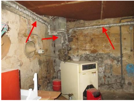
Photo n° PhA002 Localisation : Maison niveau 1 - Dégagement, Garage et Atelier Ouvrage : Flocages, Calorifugeages, Faux plafonds Partie d'ouvrage : Calorifugeages Description : Calorifugeages
