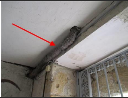
Photo n° PhA001 Localisation : Maison niveau 1 - Porche et Dégagement Ouvrage : Flocages, Calorifugeages, Faux plafonds Partie d'ouvrage : Calorifugeages Description : Calorifugeages
