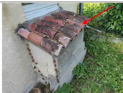
Photo n° PhA001 Localisation : Garage - Pièce 2 Ouvrage : Toitures Partie d'ouvrage : Plaques (fibres-ciment) Description : Plaques (fibres-ciment) Localisation sur croquis : ZPSO1/ZH1
