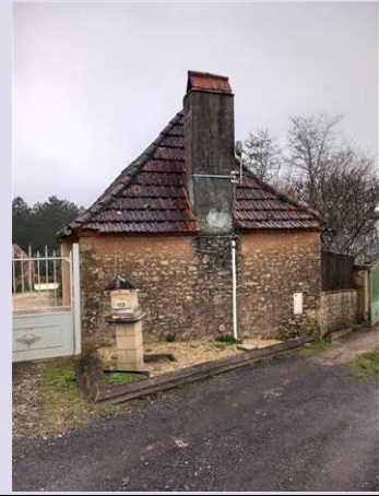
Photo PhDPE002 Ouvrage : FacadeSE
