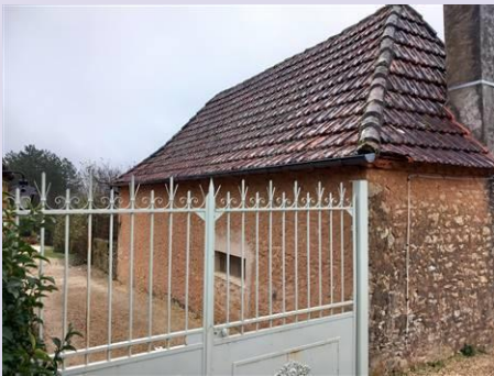
Photo PhDPE003 Ouvrage : FacadeNE
