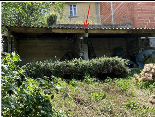
001 : fibres ciment Abri bois/Abri bois Abri bois (niv:0)
