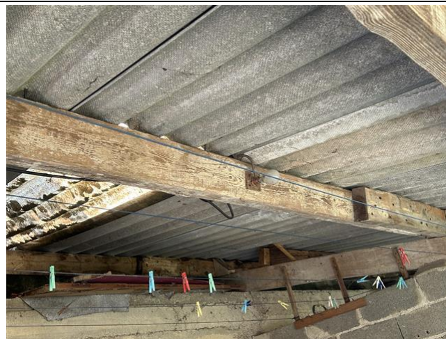
001 : fibres ciment Abri bois/Abri bois Abri bois (niv:0)
