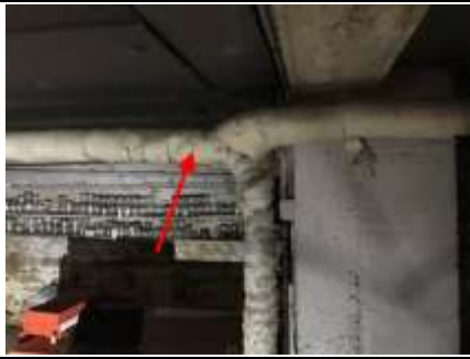
Photo n° PhA002 Localisation : 2ème étage - Grenier; Sous-Sol - Cave; Sous-Sol - Vide sanitaire Ouvrage : Flocages, Calorifugeages, Faux plafonds Partie d'ouvrage : Calorifugeages Description : Calorifugeages
