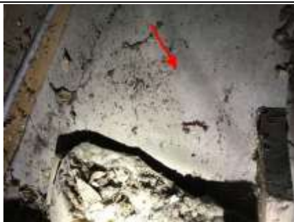
Photo n° PhA003 Localisation : 2ème étage - Grenier Ouvrage : Plafonds, Poutres et Charpentes, Gains et Coffres Horizontaux Partie d'ouvrage : Panneaux collés ou vissés Description : Panneaux collés ou vissés
