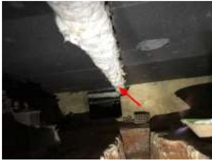
Photo n° PhA002 Localisation : 2ème étage - Grenier; Sous-Sol - Cave; Sous-Sol - Vide sanitaire Ouvrage : Flocages, Calorifugeages, Faux plafonds Partie d'ouvrage : Calorifugeages Description : Calorifugeages
