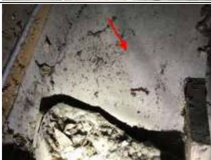
Photo n° PhA003 Localisation : 2ème étage - Grenier Ouvrage : Plafonds, Poutres et Charpentes, Gaines et Coffres Horizontaux Partie d'ouvrage : Panneaux collés ou vissés Description : Panneaux collés ou vissés
