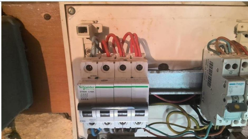
Description : A l'intérieur du tableau, la section d'au moins un conducteur alimentant les dispositifs de protection n'est pas adaptée au courant de réglage du disjoncteur de branchement.
