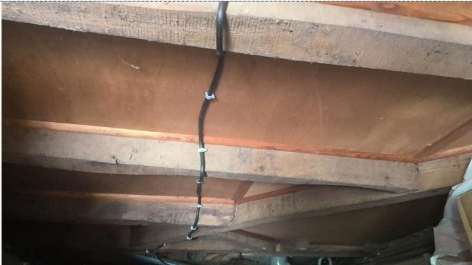
Description : Au moins un CONDUCTEUR isolé n'est pas placé sur toute sa longueur dans un conduit, une goulotte, une plinthe ou une huisserie, en matière isolante ou métallique, jusqu'à sa pénétration dans le MATERIEL ELECTRIQUE qu'il alimente.
