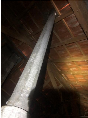
002 : fibre ciment Logement/Combles
