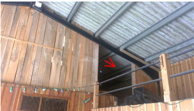
005 : amiante ciment Annexes/Hangar R+1 Annexes/Hangar R+1 (niv:1)
