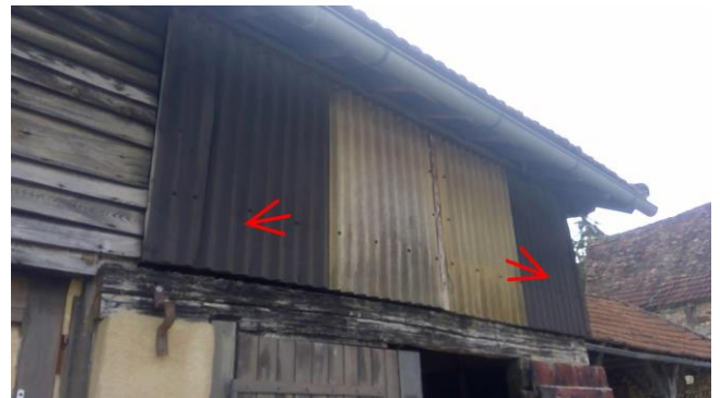
006 : Revetement bitumineux Dépendances/Garage Dépendances/Garage (niv:0) - PRE:P002
