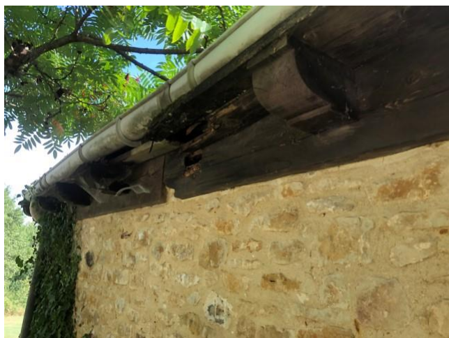
INS001 Maison - Garage / Garage PH:IMG_8455 Chaineaux Champignons (présence d'indice)
