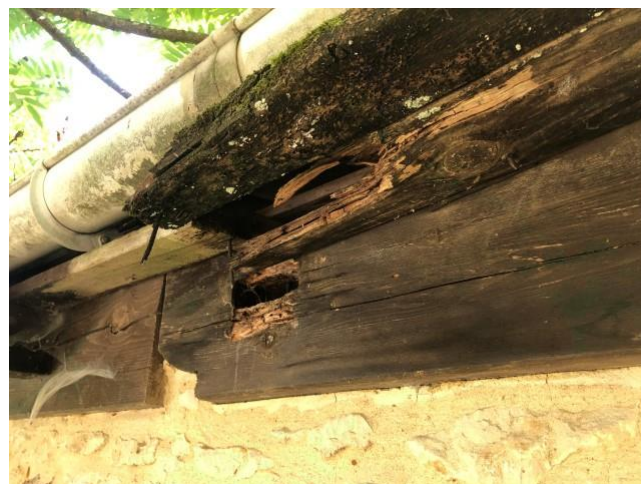
INS001 Maison - Garage / Garage PH:IMG_8456 Chaineaux Champignons (présence d'indice)
