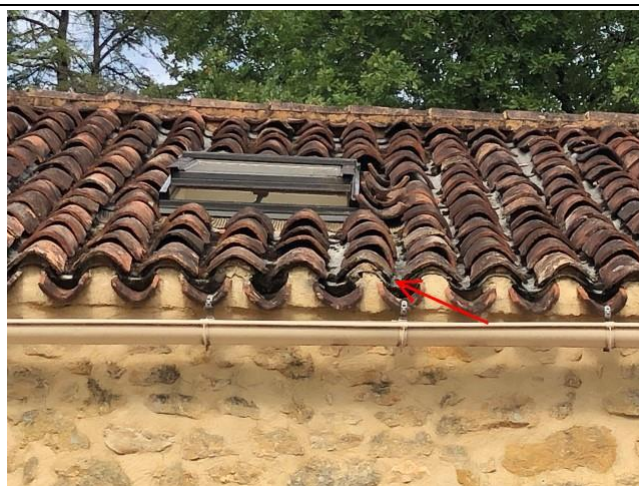
002 : fibres ciment Logement/Toiture
