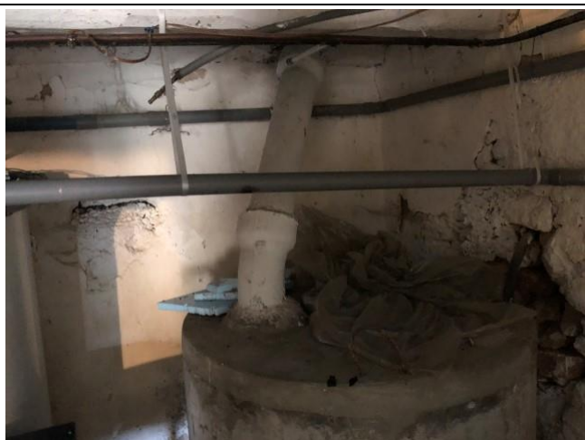
001 : fibres ciment Logement/Cave
