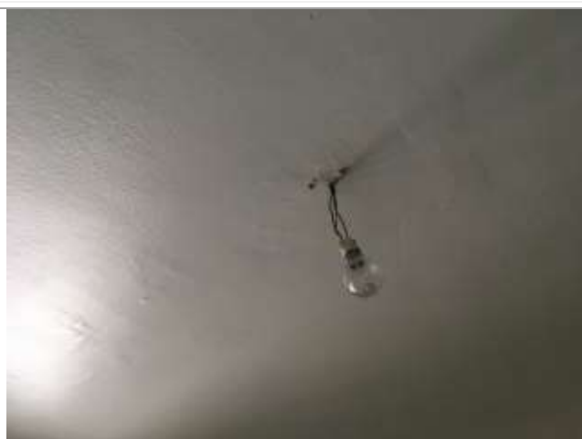
Enveloppes absentes. Douilles de chantier non conformes.
