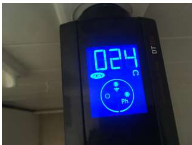
La valeur de resistance de la terre est conforme.
