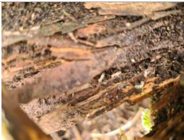
Présence d'indices d'infestation de termites (Termites vivants) bois au sol
