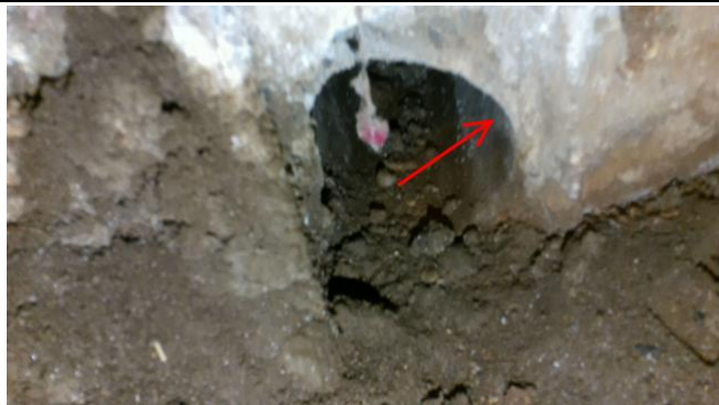
001 : amiante ciment Habitation principale/Vide sanitaire
