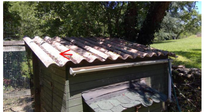
004 : Plaques ondulées en couverture Dépendances/Poulailler
