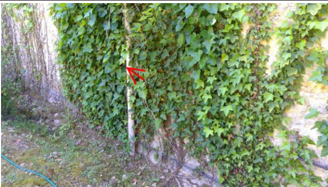
002 : amiante ciment Salon 2
