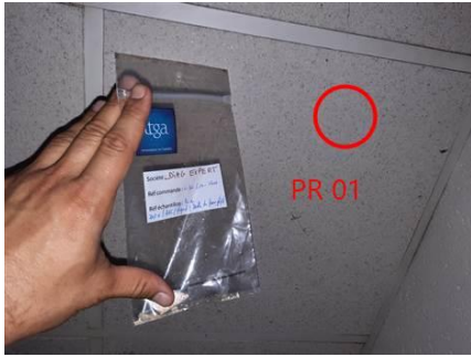
Photo n° PhA001 Localisation : Rez de chaussée - Dégagement 1 Ouvrage : Flocages, Calorifugeages, Faux plafonds Partie d'ouvrage : Faux plafonds Description : Dalles de Faux plafonds Localisation sur croquis : PR 01
