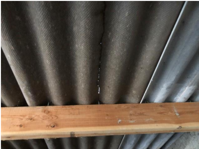
002 : fibre ciment Chaufferie/Chaufferie
