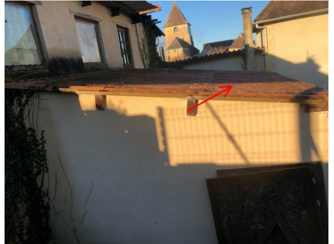
002 : fibre ciment Chaufferie/Chaufferie
