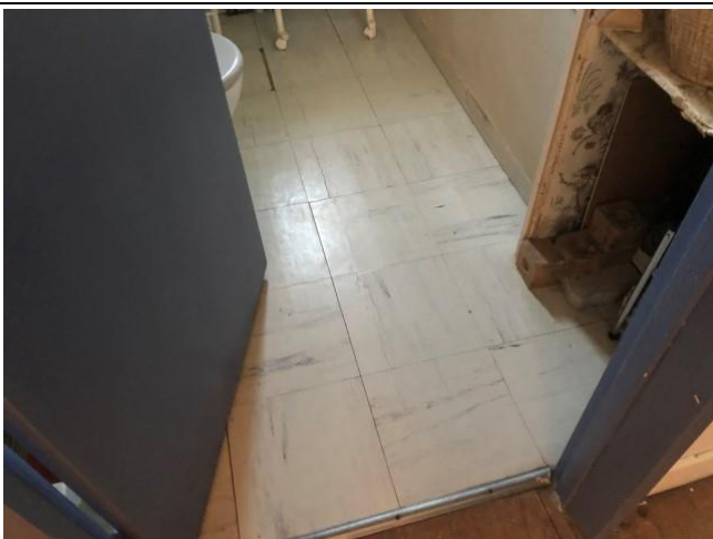
006 : Dalles de sol : plinthe Logement/Salle de bain
