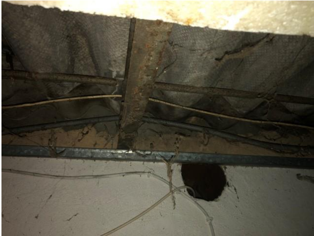
001 : fibre ciment Logement/Débarras
