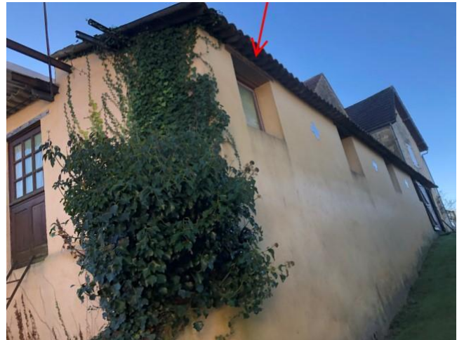
003 : fibre ciment Logement/Couloir
