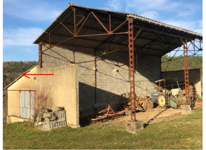
002 : fibre ciment Hangar/Atelier
