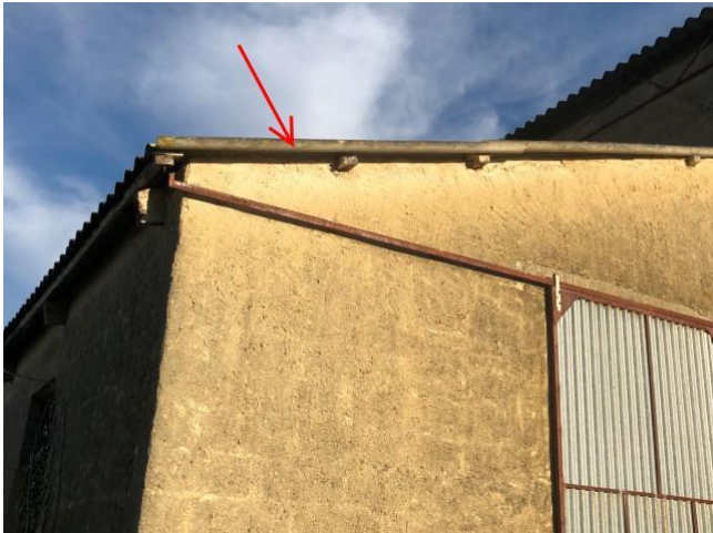
002 : fibre ciment Hangar/Atelier
