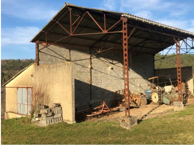
001 : fibre ciment Hangar/Hangar
