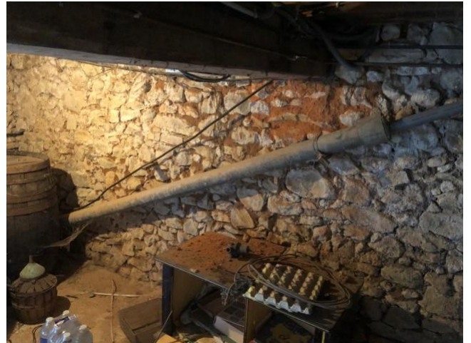
003 : fibre ciment Logement/Cave
