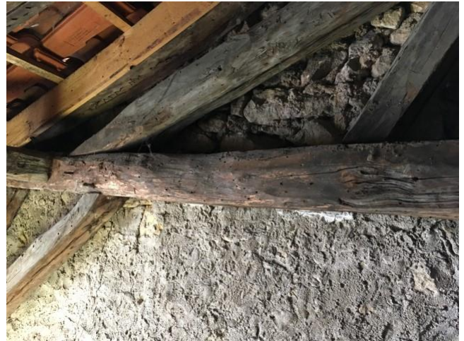
INS003 Maison - Grenier PHMP2 : charpente, Poutre maitresse Insectes à Larves Xylophages (ILX)
