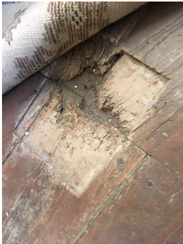
INS004 Maison - Chambre 2 PHMP4 : Plancher Insectes à Larves Xylophages (ILX)
