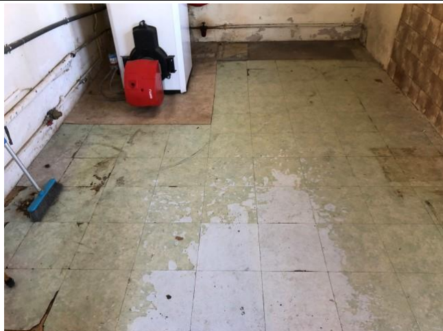
001 : Dalles de sol Logement/Chaufferie
