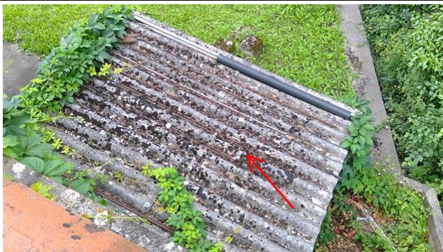
001 : Plaques ondulées en couverture Appentis
