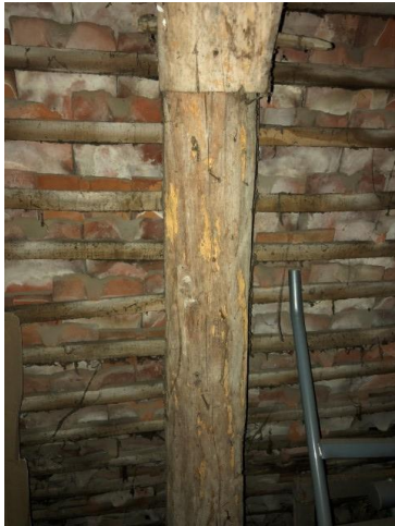
INS002 Maison - Logement / Grenier PH2 : Charpente Insectes à Larves Xylophages (ILX)
