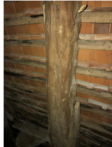
INS002 Maison - Logement / Grenier PH3 : Charpente Insectes à Larves Xylophages (ILX)
