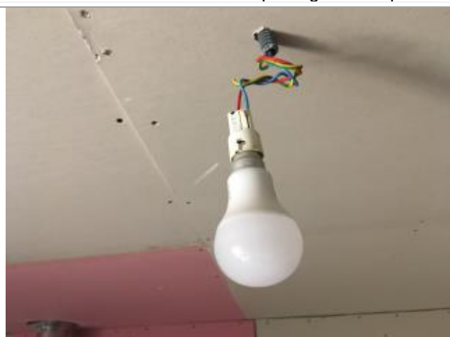
Matériel inadapté à l'usage: douille de chantier. ( chaufferie )
