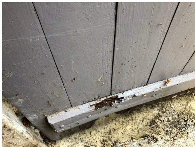
INS003 Maison - Logement / Cave PH:IMG_9831 Menuiserie (porte) Champignons (présence d'indice)
