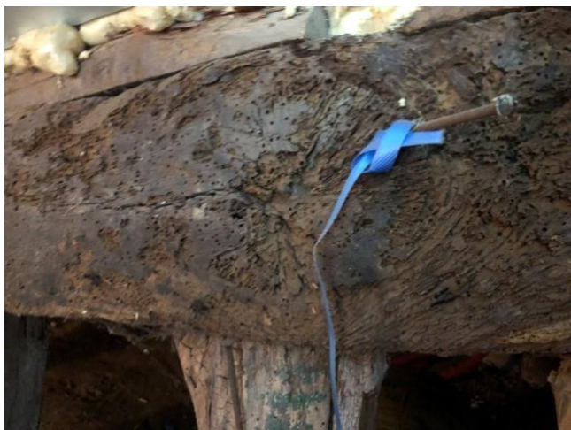
INS002 Maison - Logement / Cave PH:IMG_9830 Poutre maitresse Insectes à Larves Xylophages (ILX) (présence d'indice)
