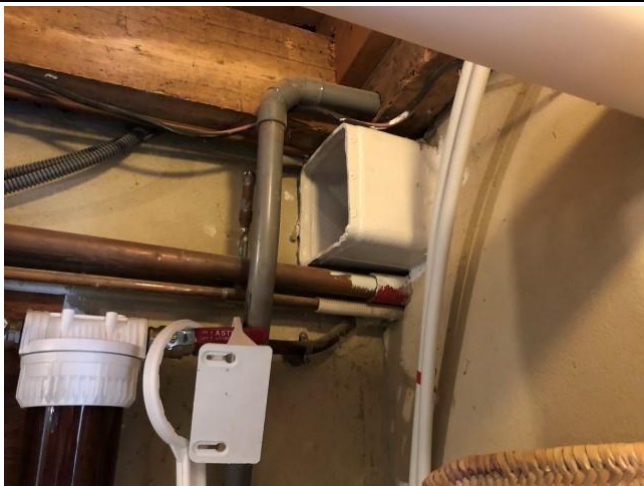
001 : fibre ciment Logement/Chaufferie
