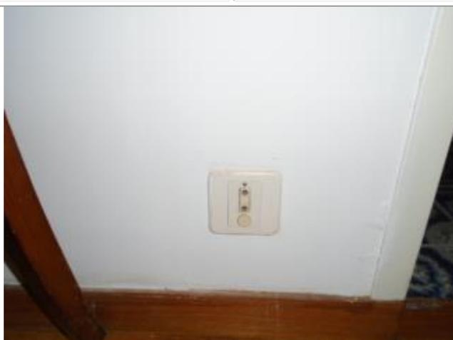
Certains circuits ne disposent pas de broche de raccordement à la terre / Absence puit de protection et d'obturateur
