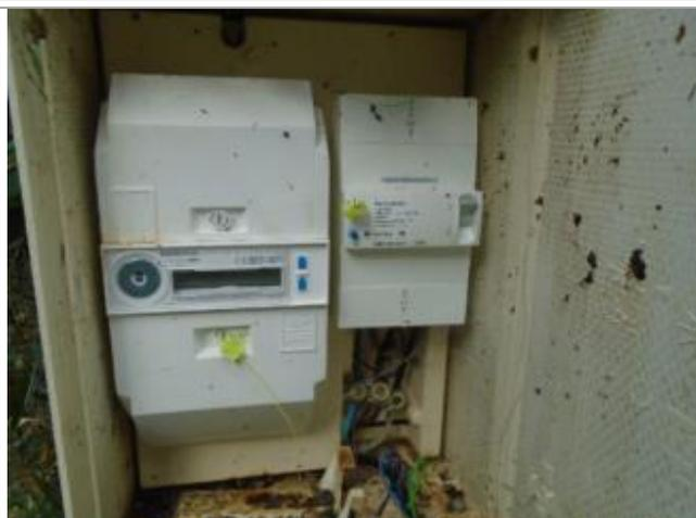
Appareil Général de Coupure et de Protection situé à l'extérieur du logement dans un coffret nécessitant un outil pour son ouverture
