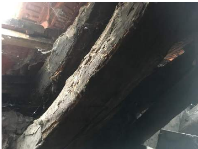
INS002 Garage - Grenier PHMP2 : Charpente Insectes à Larves Xylophages (ILX)
