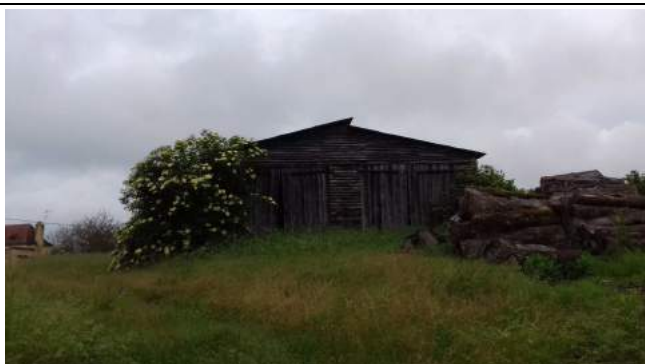
003 : fibre ciment Séchoir à tabac/Séchoir à tabac
