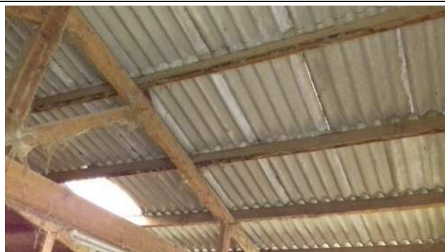
002 : fibre ciment Hangar/Bergerie
