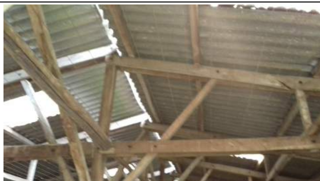
003 : fibre ciment Séchoir à tabac/Séchoir à tabac
