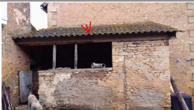
001 : fibre ciment Etable à cochons/Zone repas
