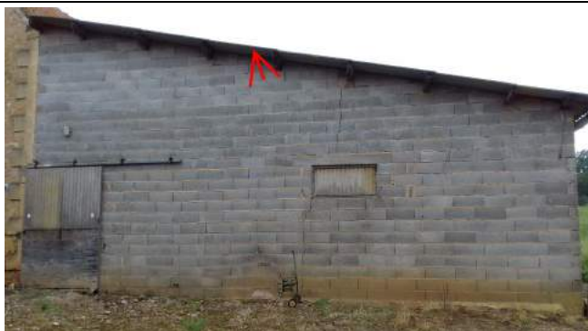
002 : fibre ciment Hangar/Bergerie
