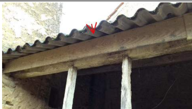
001 : fibre ciment Etable à cochons/Zone repas
