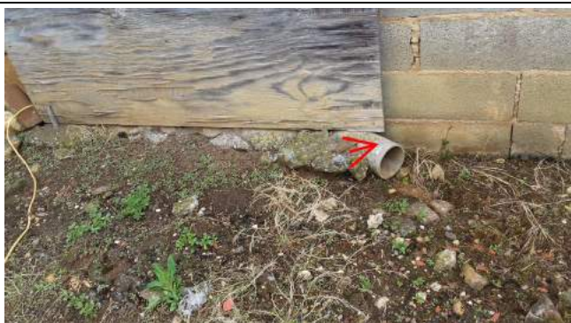
004 : fibre ciment Hangar/Bergerie
