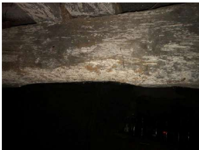
INS002 Maison - Grange / Grange PH2 : Poutre maitresse Insectes à Larves Xylophages (ILX)
