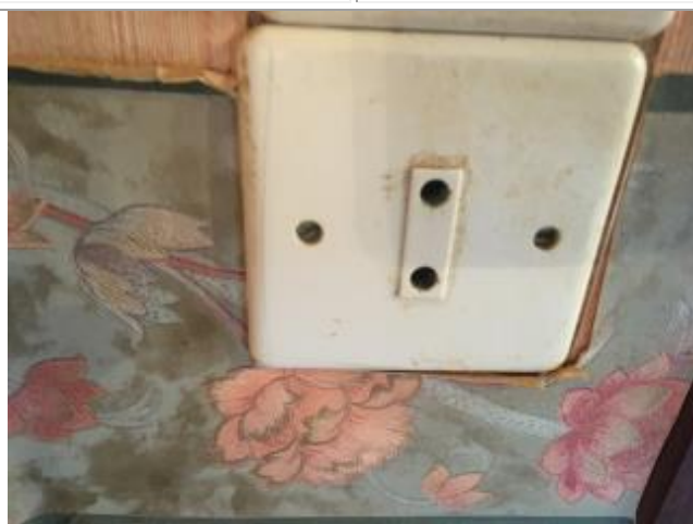
Socle de prise sans puit ni obturateurs de protection ( séjour )
