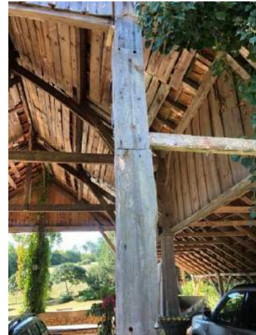
INS003 Maison - Abri voitures/Abri voitures PH4 : Poteaux Insectes à Larves Xylophages (ILX)
