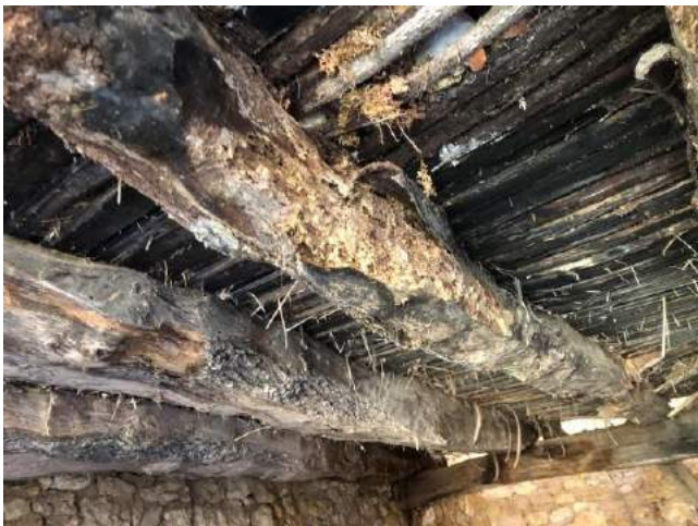
INS004 Maison - Abris boisièce 1 PH5 : Poutre maitresse Insectes à Larves Xylophages (ILX)
