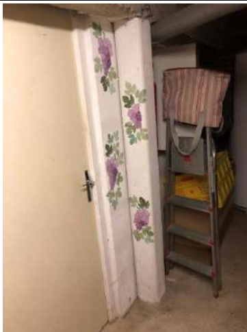
001 : fibre ciment Maison principale/Réserve
