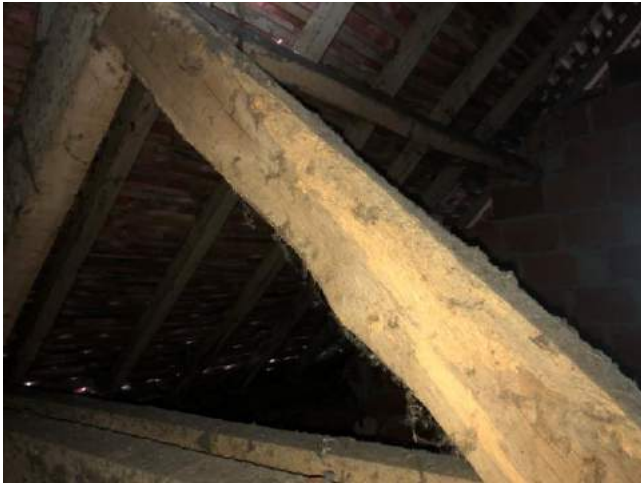
INS002 Maison - Combles PH3 : Charpente Insectes à Larves Xylophages (ILX)
