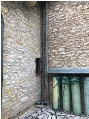
001 : fibre ciment Façade mur extérieur
