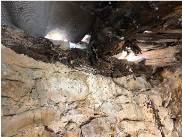
INS008 Maison - Dépendances/Débarras PH6 : Linteau Termites souterrains
