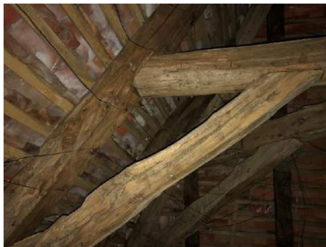
INS003 Maison - Maison principale/Grenier PH9 : Poutre maitresse Insectes à Larves Xylophages (ILX)
