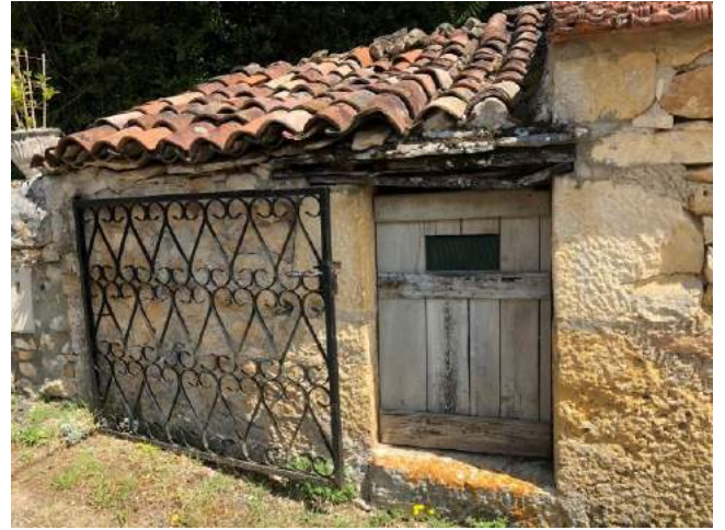
INS008 Maison - Dépendances/Débarras PH5 : Linteau Termites souterrains
