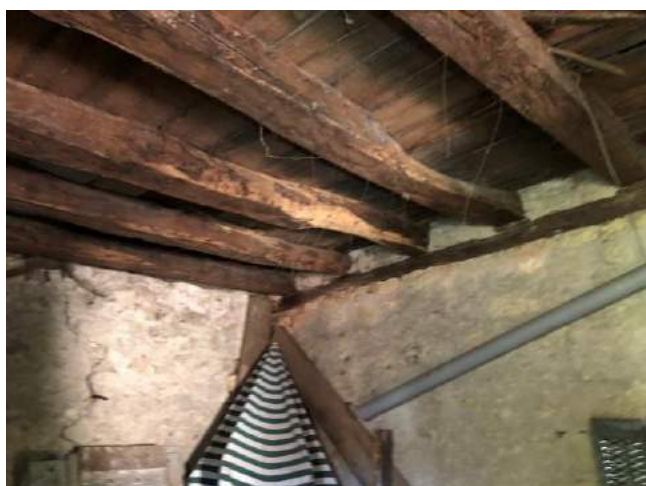
INS004 Maison - Dépendances/Four à pains PH2 : Poutre maitresse Insectes à Larves Xylophages (ILX)
