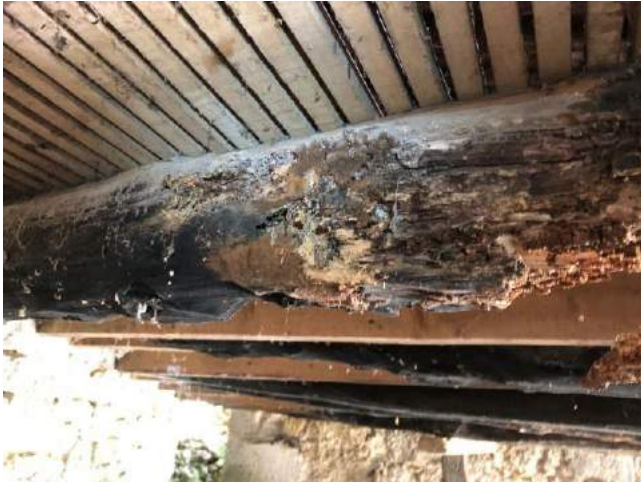
INS007 Maison - Dépendances/Four à pains PH4 : Poutre maitresse champignons
