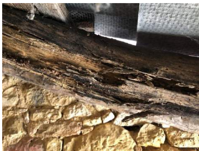
INS005 Maison - Dépendances/Débarras PH7 : Poutre maitresse Termites souterrains
