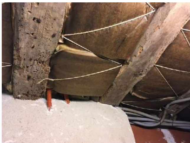
INS002 Maison - Garage PH2 : Poutre maitresse Insectes à Larves Xylophages (ILX)
