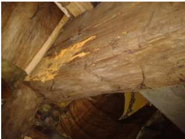
INS016 Maison - Grenier PHMP2 : charpente Capricorne
