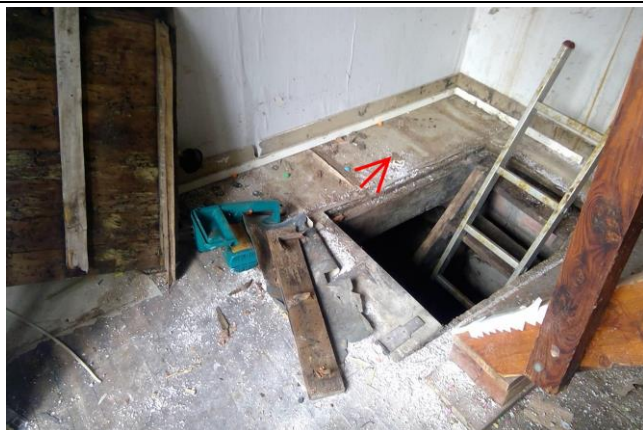
001 : Linoléum Habitation/accès grenier/cave Habitation/accès grenier/cave (niv:0) - PRE:MB001
