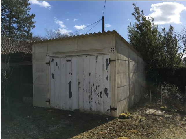
001 : fibre ciment Garage extérieur
