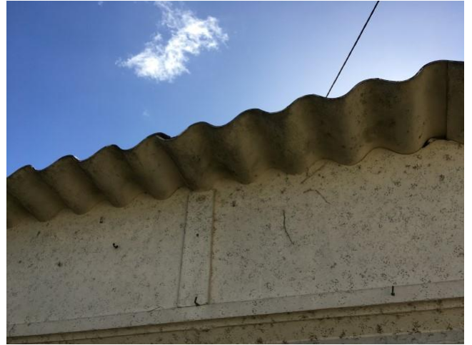
001 : fibre ciment Garage extérieur
