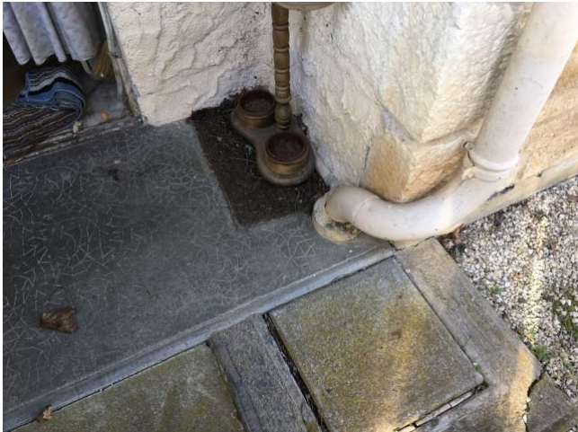
002 : fibre ciment Façade mur extérieur
