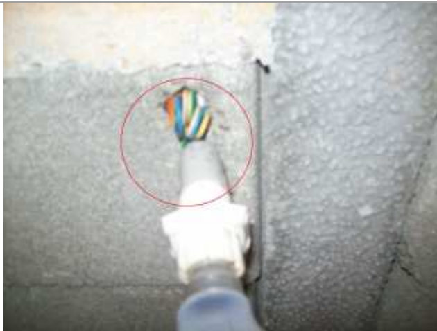
conducteurs non protégés - douille de chantier
