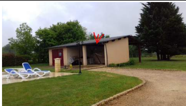
002 : fibre ciment Dépendance/Auvent
