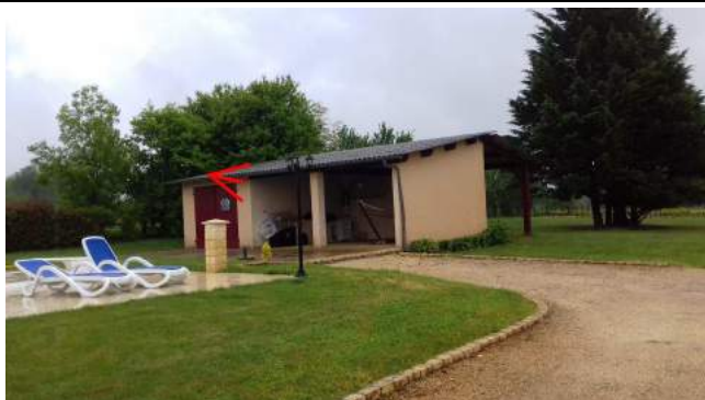
001 : fibre ciment Dépendance/Local technique piscine
