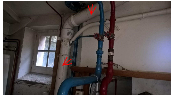
004 : amiante ciment Batiment n°27/Chaufferie
