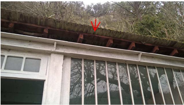
005 : Plaques ondulées fibres ciment Batiment n°27/Local cuve
