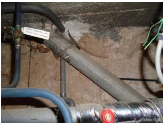
22 Chaufferie \ Réf: R1 Conduits Conduits de fluides
